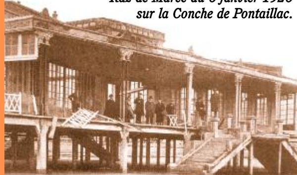
*La terrasse et la balustrade de la "Restauration" sont ravagées. Quant aux cabines de bains construites en 1902 sur la partie ouest de l'esplanade, leur structure en bois n'a pu résister au raz de marée. Portes défoncées, cabines disloquées, escaliers d'accès arrachés du parapet montrent la violence du séisme.*
